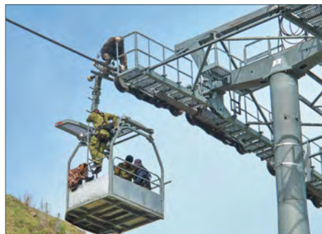
Construction de téléphérique
