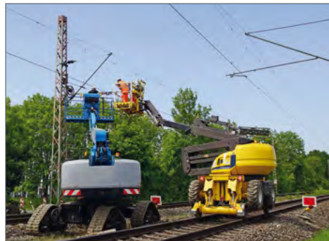
Construction de caténaires
