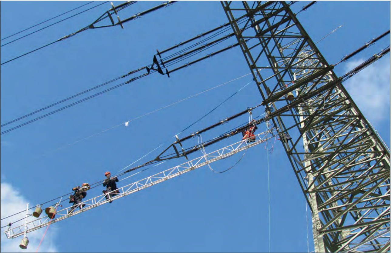
Construction de lignes électriques aériennes
