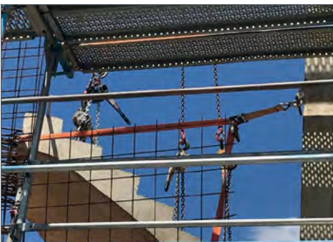
Travail de positionnement avec charges dynamiques Spécialement lors d'utilisation d'élingues chaîne (ex: installations de turbines)
